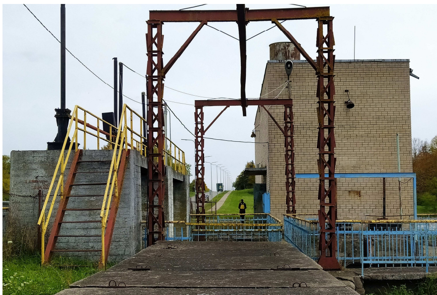
30 pav. Atsarginių uždorių-skydų iškėlimui ir pastatymui įrengtas keltuvas su sija ant metalinių atramų konstrukcijos Kėlimo mechanizmas nuimtas, talpinamas atskirai, Atramos ir sija nežymiai deformuotos, su vietomis nusilupusiu dažų sluoksniu. Atramos suvirintos iš smulkių metalo konstrukcijų, neturi estetinio vaizdo.
