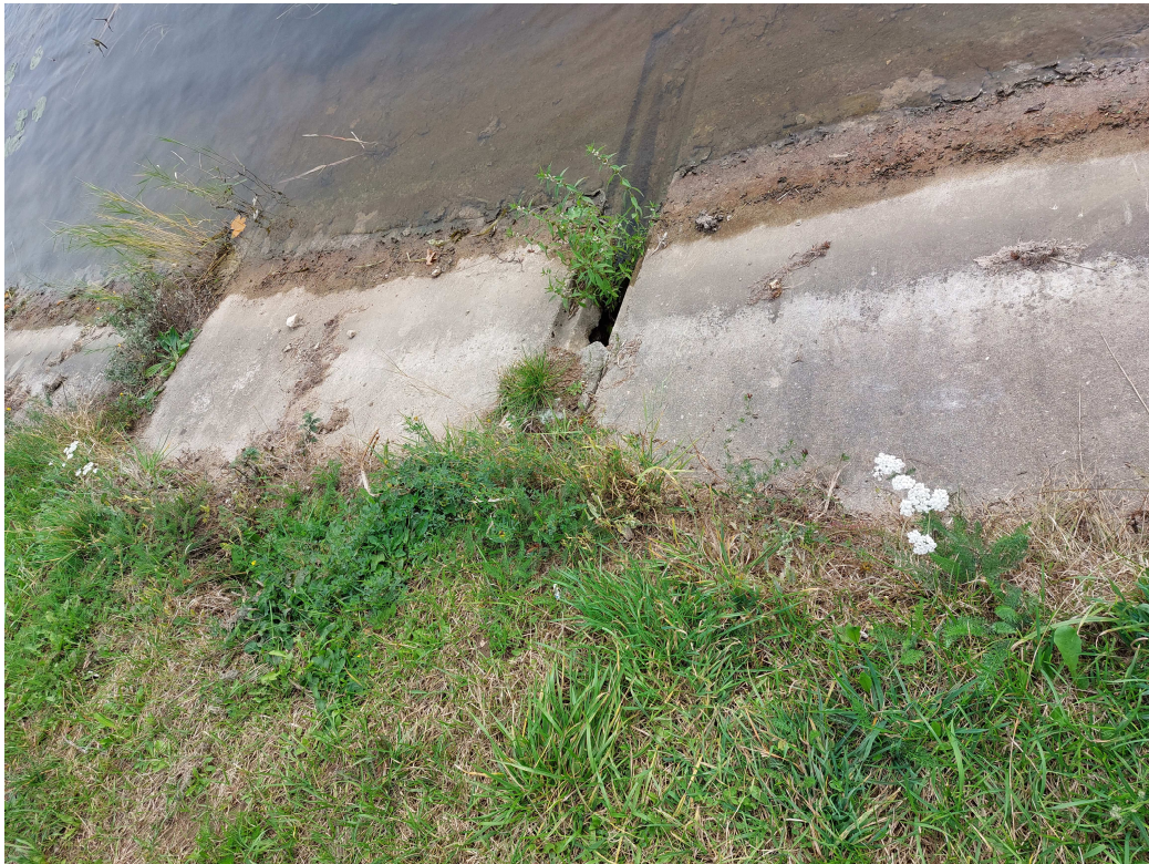
6 pav. Ties vandens svyravimo zona vietomis plokščių siūlų betonas ištrupėjęs, po plokštėmis išplautas gruntas.
