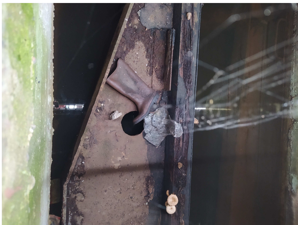
26 pav. Uždorių metalo konstrukcijos pažeistos korozijos, medinės dalys supuvusios.
