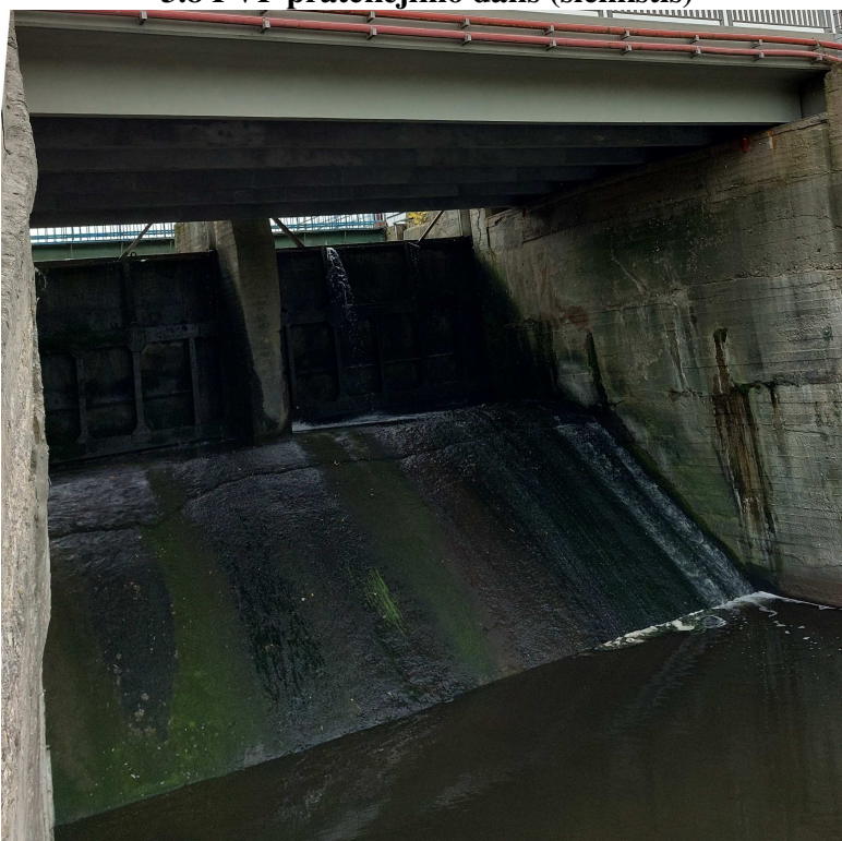
31 pav. PVP pratekėjimo dalis - praktinio profilio GB nuopyla su atraminėmis sienomis (ramtais) ant kurių laikosi tilto konstrukcija. Betonų paviršiai paveikti abrazyjos, sušiuurkštėję nuo vandens tėkmės ir čiurkšlių poveikio. Nusėdimo ar pakrypimo požymių nėra.
