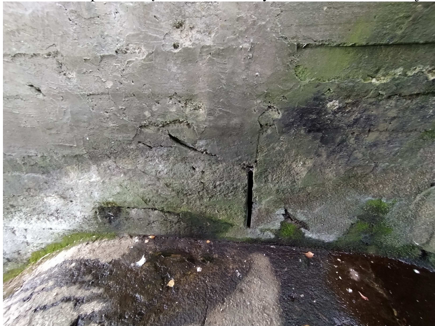
33 pav. Dešiniojo ramto žemutinėje dalyje yra plyšių betone, ties ramto ir nuopylos sujungimu išsikrauna filtracinis vanduo, nusidėvėjęs betono sluoksnis nuopylos viršuje. Sienose matosi betono karbonizacijos požymiai.
