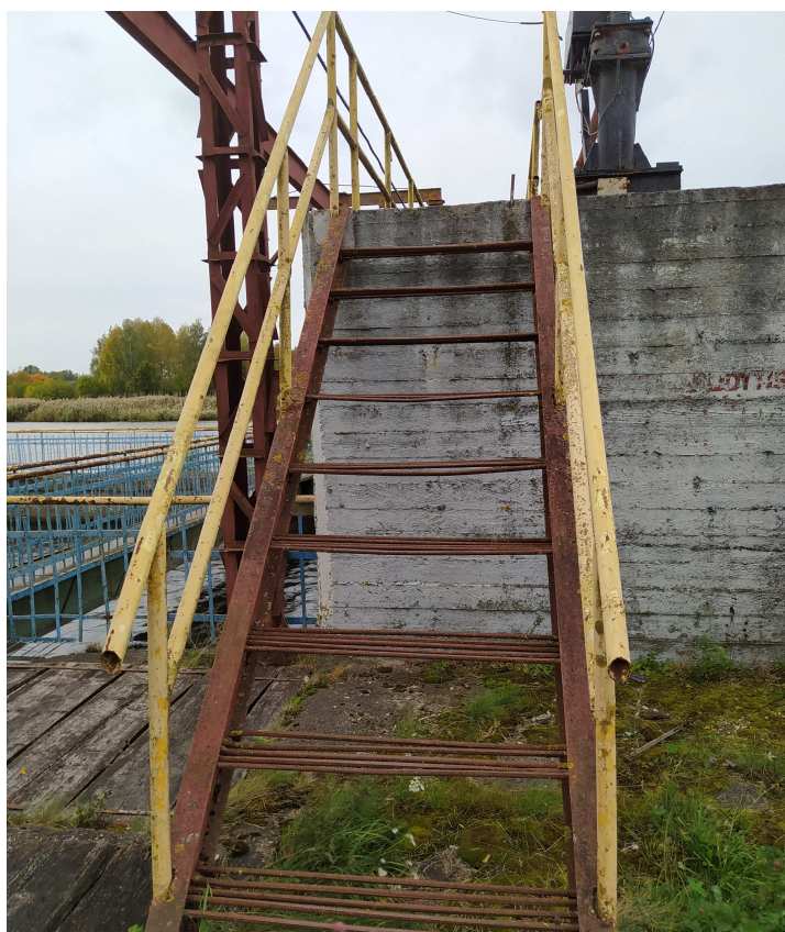
39 pav. Metaliniai laiptai įrengti iš abiejų tiltelio pusių. Laiptai nestabilūs, metalo konstrukcijos aprūdijusios, pakopos suvirintos iš armatūros strypų, deformuotos, nesaugus laipiojimas.
