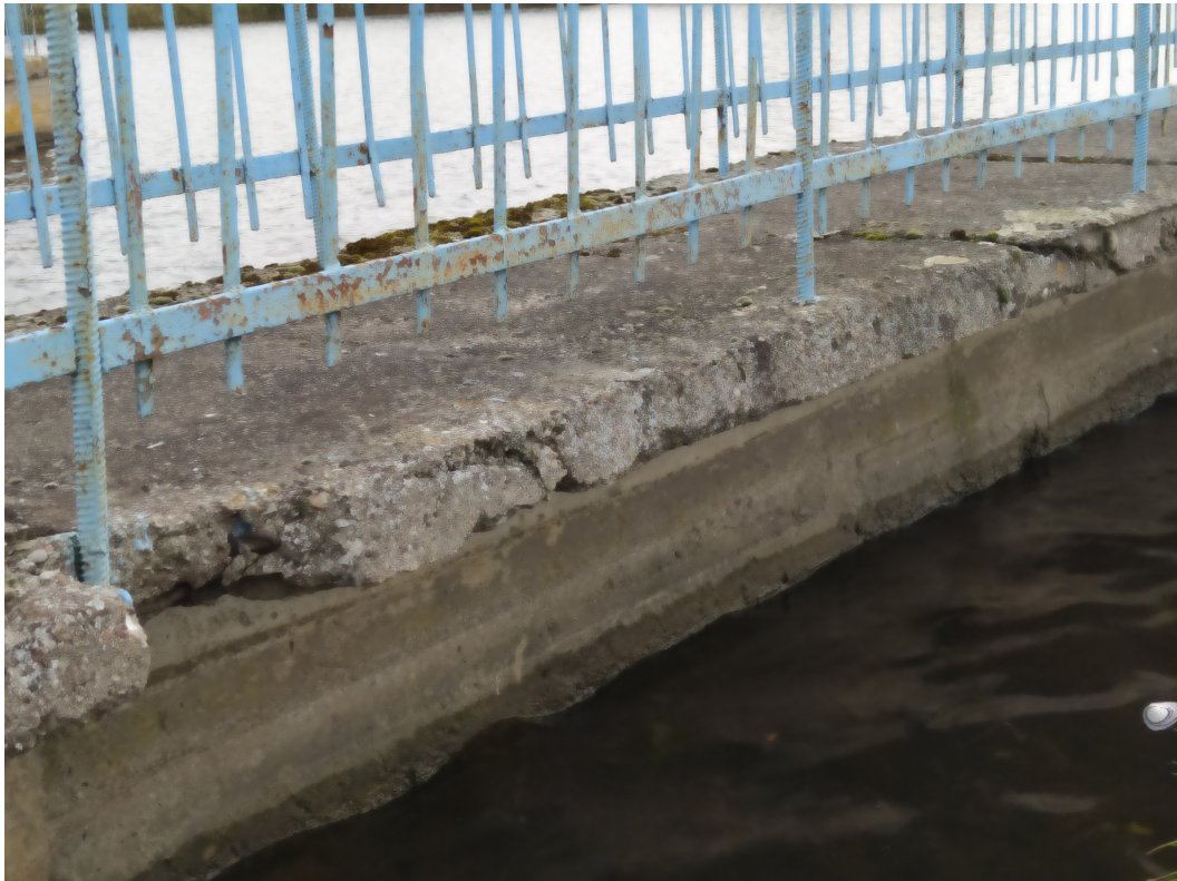
16 pav. Tiltelio danga sutrūkusi, kraštuose nutrupėjęs betonas.
