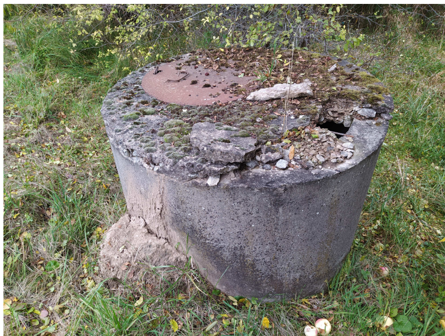
11 pav. Dešinėje užslenkstės pusėje esantis drenažo šulinys susidėvėjęs, dangčio betonai sutrupėjęs, nesandarūs.
