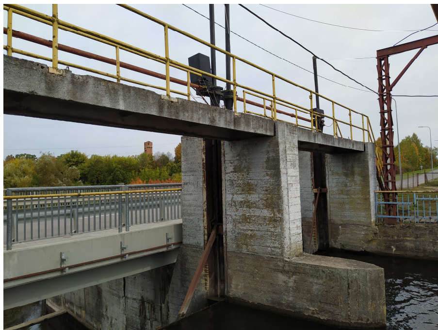
43 pav. Statinio rekonstravimo metu uždorių kilnojimui buvo įrengti 3 taurai. Taurų konstrukcijoje žymesnių deformacijų ir betono pažeidimų nenustatyta. Esamų vertikalinių sienų ir naujai įrengtų taurų sujungimai išbetonuoti netinkamai (yra plyšių ir betono nelygumų)
