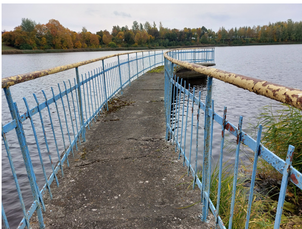
15 pav. Kairiojo įtekėjimo sparno atramos ir tiltelio betonas vietomis nusidėvėjęs, atramos betonas ties vandens lygiu nutrupėjęs.
