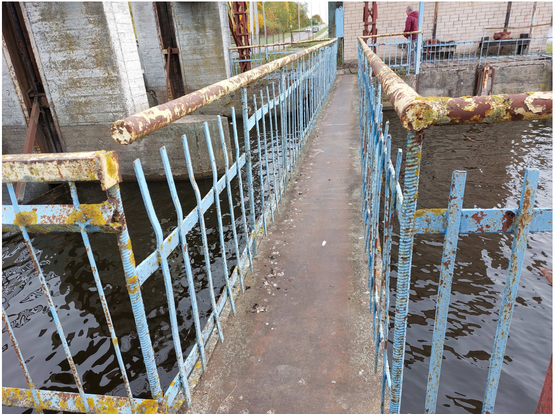
41 pav. Tiltelis, skirtas praėjimui tarp įtekėjimo kairiojo ir dešiniojo sparno, įrengtas šalia atsarginių skydų įleidimų vietos. Tiltelis metalinis, konstrukcijos aprūdijusios, nestabilios, seniai dažytos.
