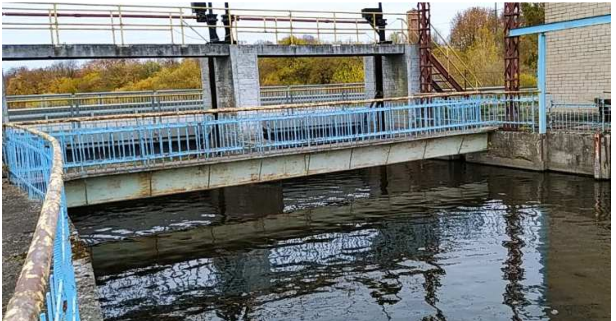
42 pav. Tiltelio laikančioji konstrukcija suvirinta iš pavienių metalo lakštų. Žymesnių tiltelio deformacijų nepastebėta, tačiau bendra konstrukcija nepakankamai stabili.
