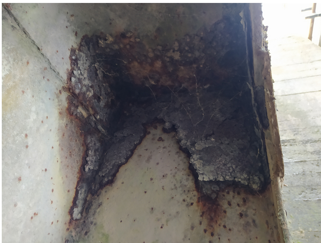
23 pav. Uždorių metalo konstrukcijos stipriai pažeistos korozijos, vandenį sulaikantysis skydas suplonėjęs apie 5 mm.
