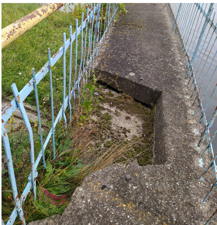
18 pav. Dešinys įtekėjimo sparnas su išpjauta ir neatstatyta tiltelio dalimi. Tiltelio viršaus ir atramos ties vandens svyravimo lygiu betonas vietomis nutrupėjęs.
