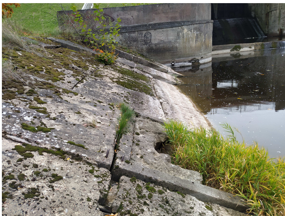
47 pav. Dalis plokščių sutrūkusios (keletas visai sutrupėjusios), paplautos po plokštėmis supiltas skaldos pasluoksnis. Dalies plokščių viršus nutrupėjęs.
