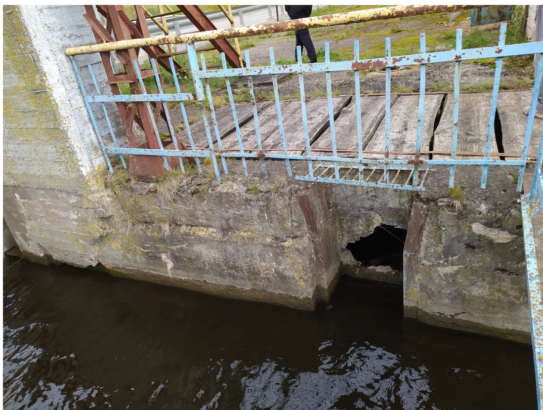
27 pav. Ties atsarginių uždorių įleidimo vieta ištrupėjęs sienos betonas, metalo konstrukcijos aprūdijusios.
