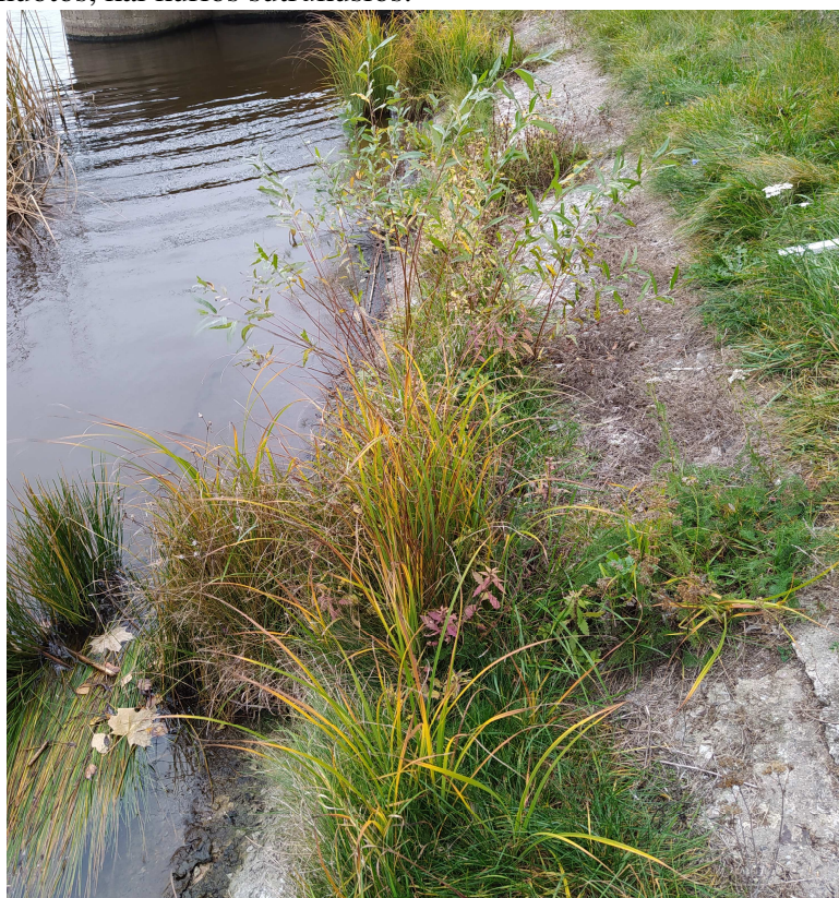
5 pav. Dešiniojoje aukštutinio šlaito pusėje nuo įtekėjimo tvirtinimo plokščių siūlės ištrupėjusios ir apaugusios žolėmis bei velėna.
