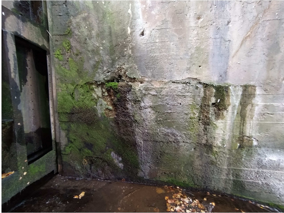
32 pav. Kairiojo ramto žemutinė dalis nelygi, betonavimo metu išsikraipius klojiniams, atsiradę betono nelygumai (iškilimai ir įdubimai) Ties betonavimo siūlėmis ištrupėjęs betonas, per siūles prateka filtracinis vanduo, vietomis sienose paliktos įbetonuotų klojinių liekanos. Ties taurų ir sienos sandūra pastebimas vandens prasifiltravimas per betoną, sienose matosi žymūs betono karbonizacijos požymiai.
