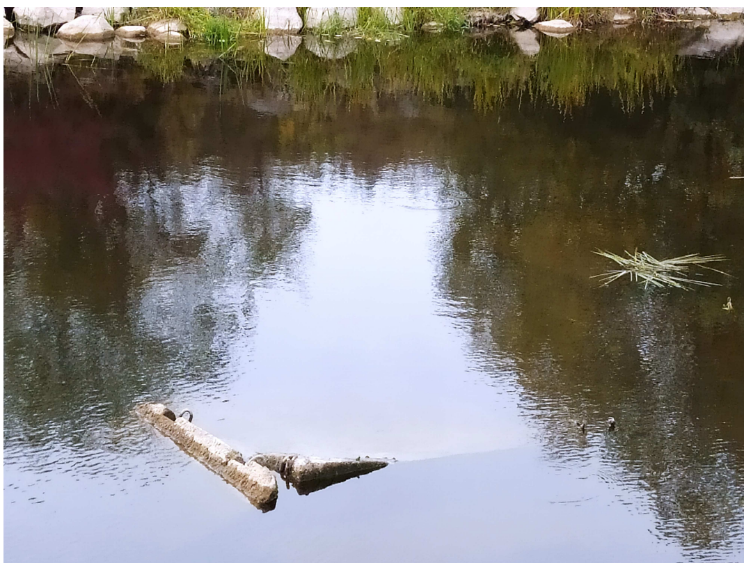
48 pav. Ties risbermos galu keletas dugno tvirtinimo plokščių yra paplautos, dėl ledų poveikio išvartytos.
