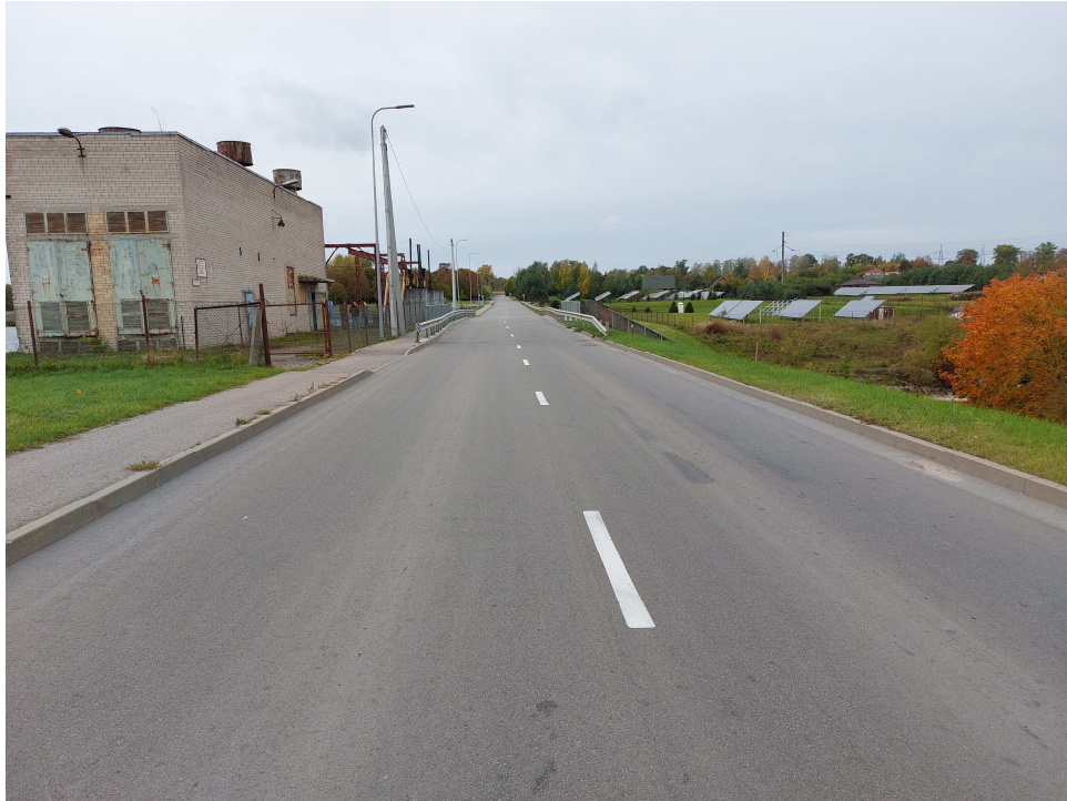
2 pav. Užtvankos keteroje įrengta Marių gatvė su asfaltbetonio danga. Gatvė rekonstruota prieš keletą metų. Ties PVP įtekėjimo dalimi virš slenksčio esantis tiltas rekonstruotas.
