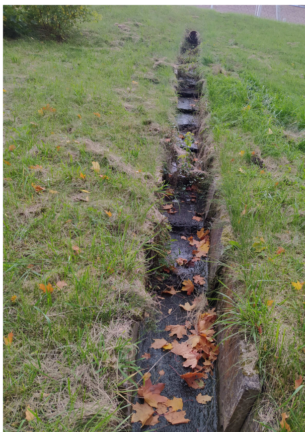
9 pav. Vandens nuleidimui nuo kelio dangos šlaite įrengtas latakas, jo elementai deformuoti, keletas sulaužyti, vanduo prasigraužęs pro lataką apačią.
