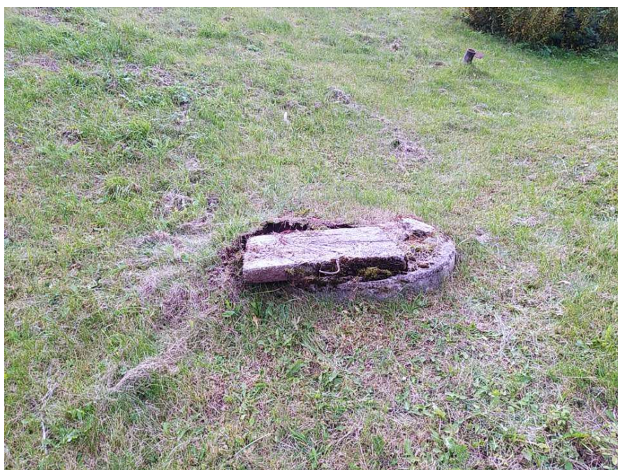
14 pav. Drenažo šulinys kairėje užslenkstės pusėje yra uždengtas netinkamai. Viršutinio žiedo betonas aptrupėjęs.
